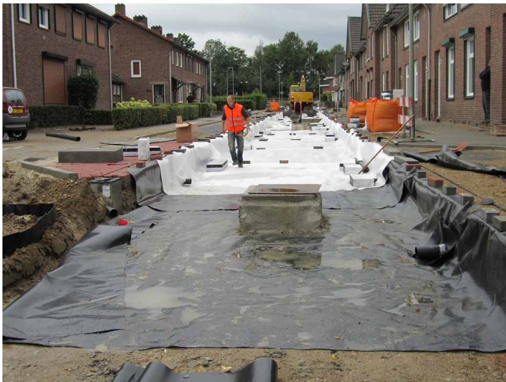
Figuur 2-5: Bergend systeem (folie onderin het cunet) met hulpstukken voor het aansluiten van kolken en daken
