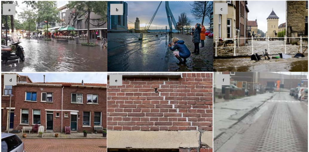
Figuur 6. Effecten op de gebouwde omgeving als gevolg van extreem weer in een veranderend klimaat: (a) wateroverlast op de Kruiskade door extreme neerslag in 2017 (bron: Groenendijk & Venema, 2017. ©Vera Baumann); (b) hoogwater op het Noordereiland in 2018 (bron: Redactie Rotterdam, 2020. ©Frank de Roo); (c) overstroming in Valkenburg in 2021 (De Gelderlander, 2023. ©ANP); (d-e) scheefstand bij huizen en scheurvorming in gevels door bodem- en grondwaterstands daling (bron: KBF, z.d. ©onbekend; Gemeente Rotterdam, z.d. ©onbekend) (f) spoorvorming aan de weg (©Steve Ekel)
