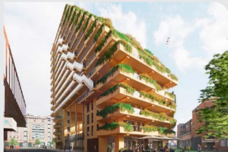
SAWA Rotterdam, volledige houtbouw hoogbouw.
