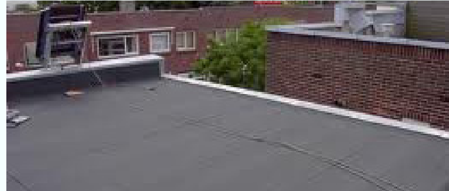
Figuur 20. Bitumendak. Bron: dakweb.nl
